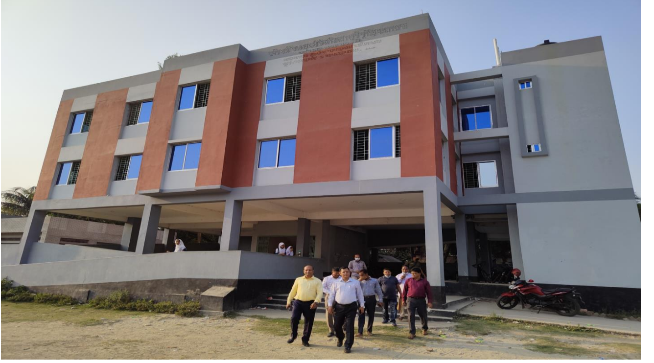
চিত্রঃ ০৩ জনাব অঞ্জন চন্দ্র পাল, প্রকল্প পরিচালক এর কুমিল্লা জেলার সদর দক্ষিণ উপজেলাধীন বামিশা এ আর উচ্চ বিদ্যালয় বহুমুখী ঘূর্ণিঝড় আশ্রয়কেন্দ্র নির্মাণ প্রকল্পস্থল সরেজমিন পরিদর্শন।
